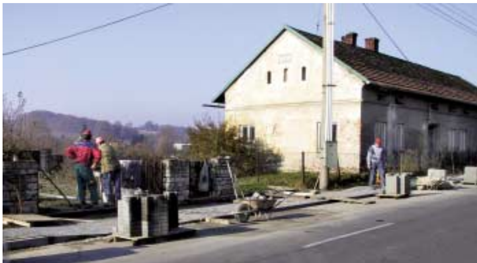
Výstavba chodníku na ulici Staroveská
