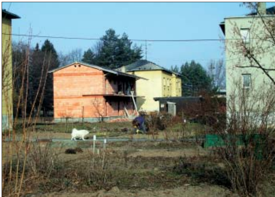
Stavba bytového domu v areálu obecních domů na Závodí pokračovala i v mrazivých únorových dnech
