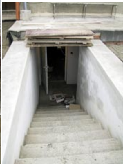
Na fotbalovém hřišti se kompletují koupelny v suterénu klubové budovy.
