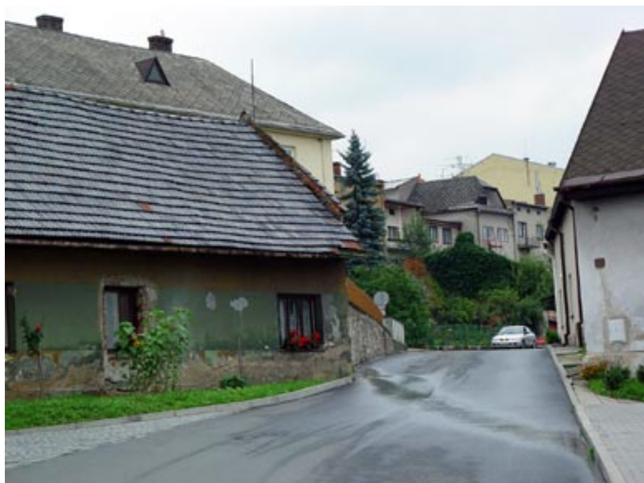
Pravděpodobně vadná kanalizace na ulici Dr. Martíňka
