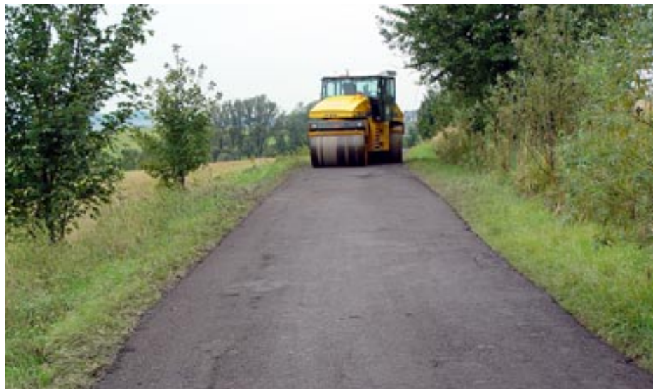
Cesta od přehrady k Obecnímu lesu je opravována recyklátem a bude výbornou vozovkou pro cyklisty
