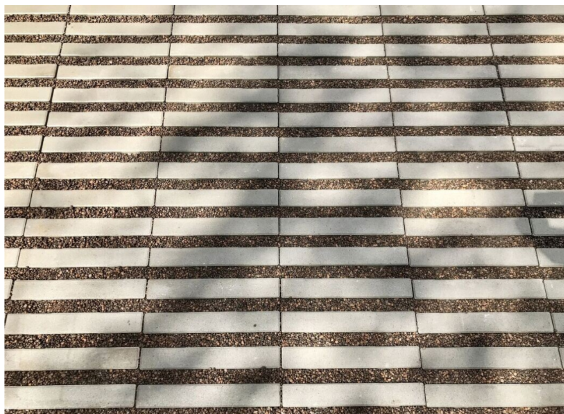
Betonová zatravňovací dlažba vyplněna štěrkodrtí
