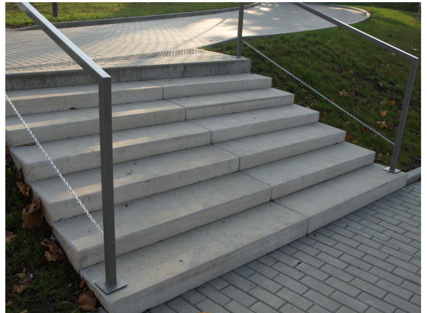
nebo betonové schodiště prefabrikované schodišťové stupně
