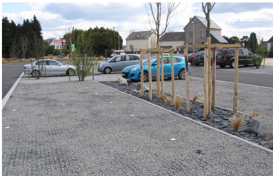
Zatravňovací tvárnice vyplněna štěrkodrtí
