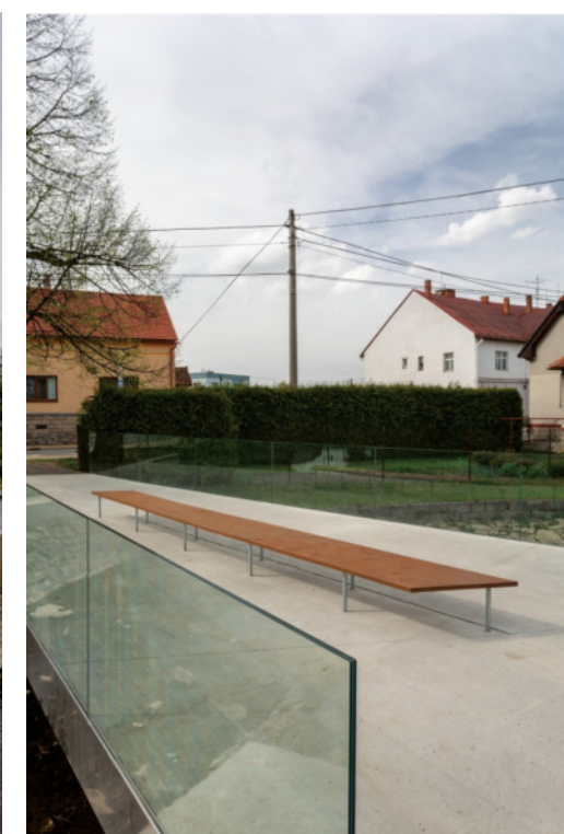
Lávka pro pěší v Palkovicích Autor: Kamil Mrva Architects | Kamil Mrva
