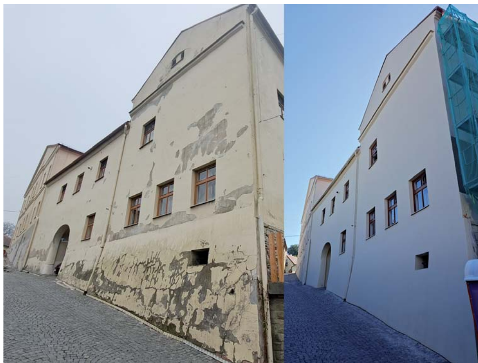
Fasáda MěÚ – před a po.
