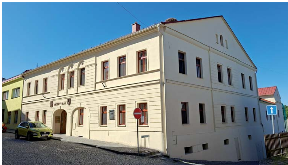
Fasáda MěÚ – po opravě.
