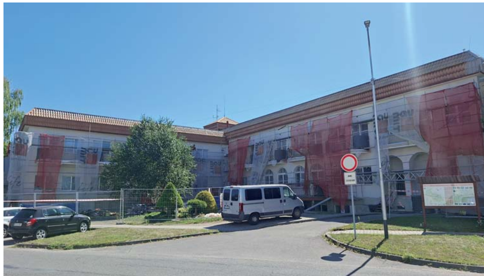
Oprava vnějšího pláště domova seniorů (před dokončením).
