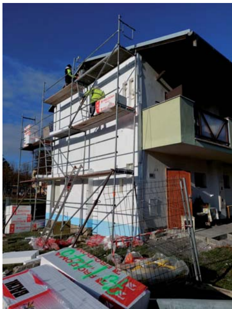
Zateplení štítových stěn malometrážních bytů.
