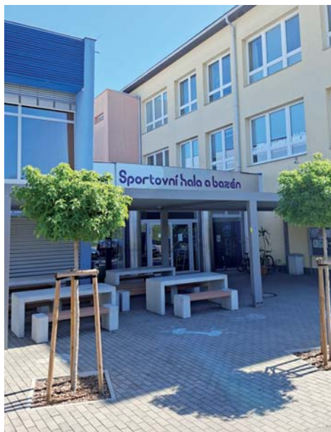
Pergola a mobiliář u vstupu do sportovní haly a na bazén.
