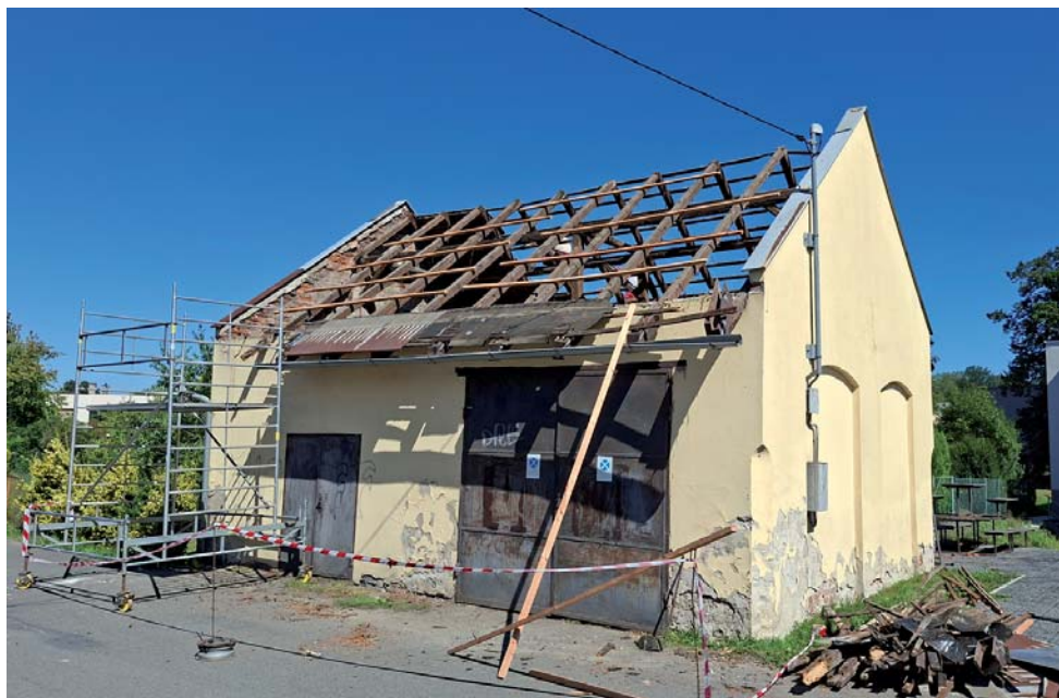
Opravy nově pořízené stodoly.
