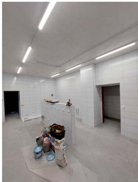
Rekonstrukce kuchyně v restauraci U Hynečků.
