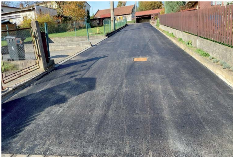
Oprava komunikace – ulice Valy.
