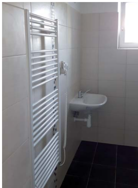
Příklady oprav bytového fondu města.
