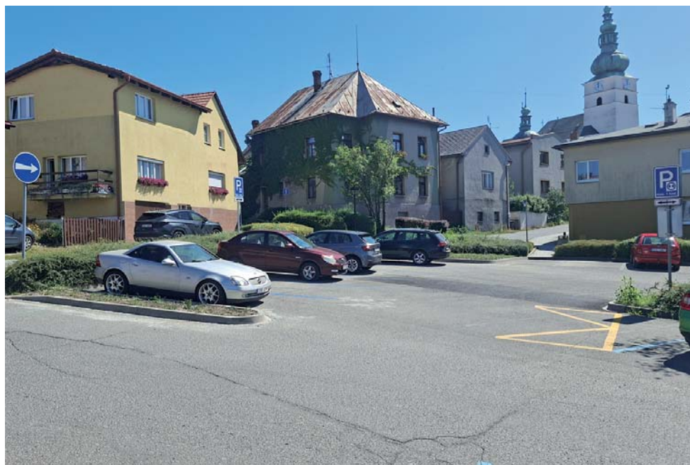
Úprava výjezdu z parkoviště u Hrušky.
