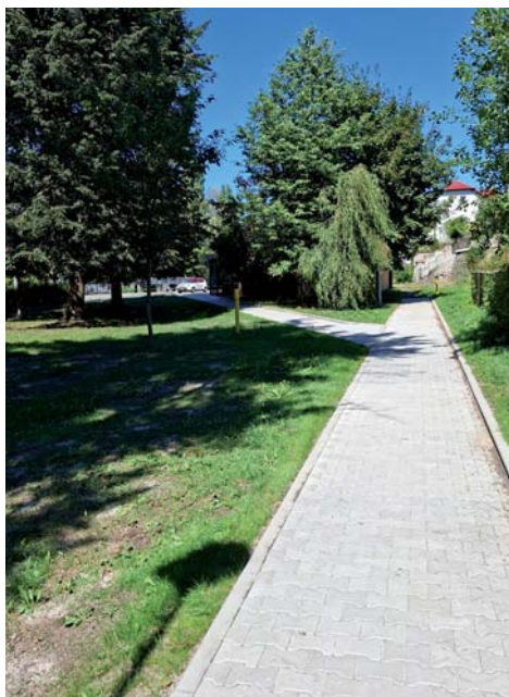
Opravený chodník u parku Brušperk Střed.
