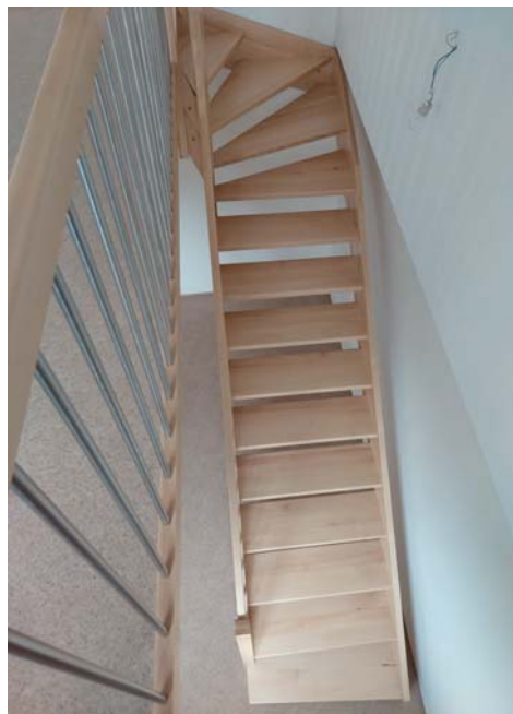
Příklady oprav bytového fondu města.
