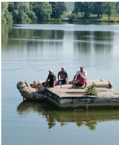
Ve spolupráci s brušperskými hasiči byla provedena oprava stavidla na rekreační vodní nádrži.
