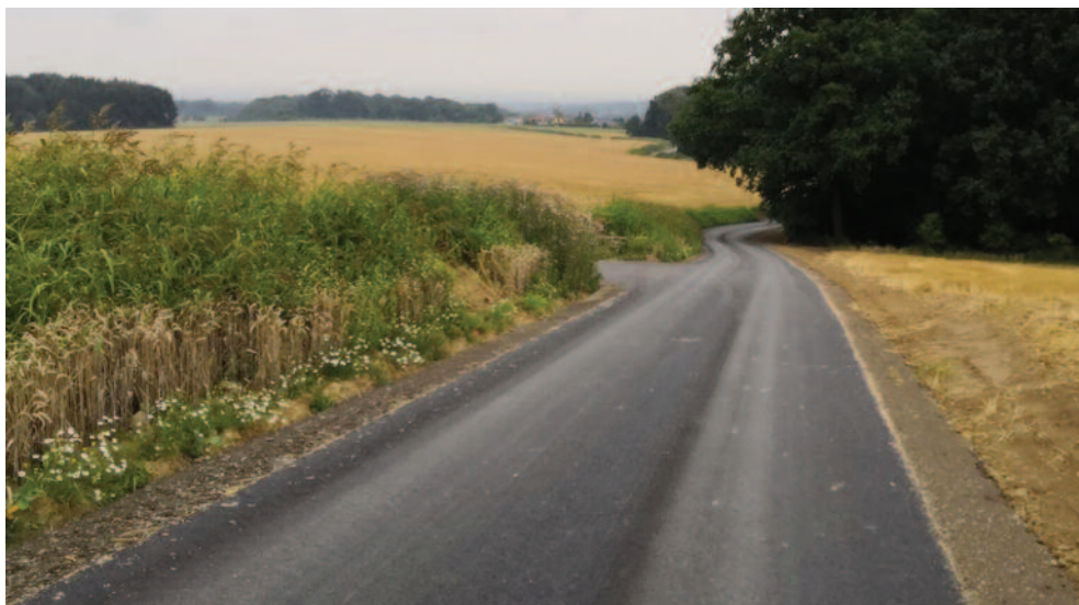
Dokončení stavby hlavní polní cesty na spojnici od sv. Marka až na katastr Staré Vsi n. O.
