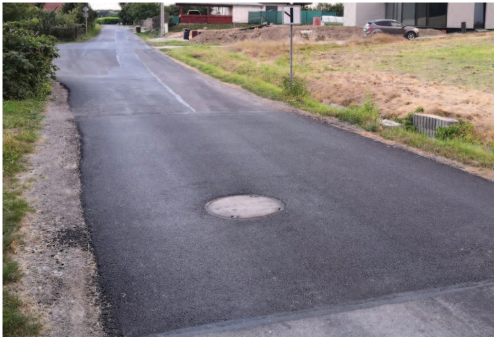
Oprava živičného povrchu ulice Dráhy směr k přehradě č. I.
