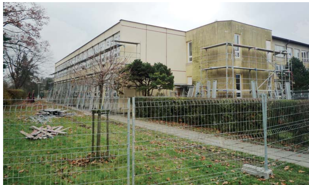
Oprava školní budovy.
