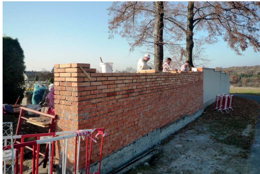
Stavba urnové zdi na našem hřbitově.
