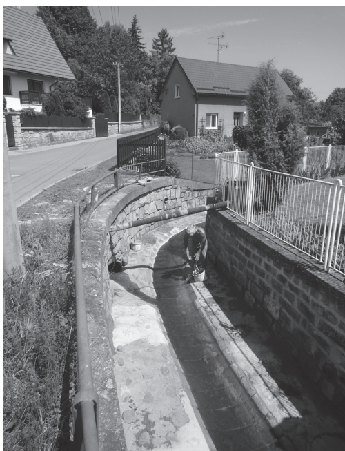
Oprava koryta Horního Kořbachu
