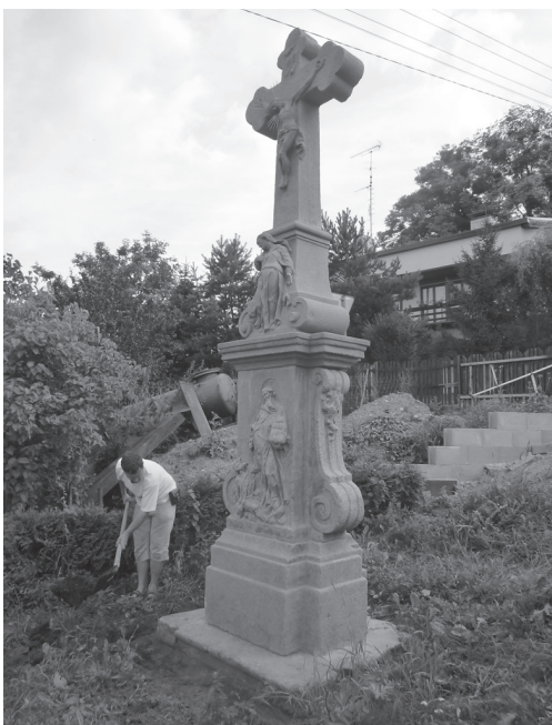
Oprava kříže na ul. Borošínská
