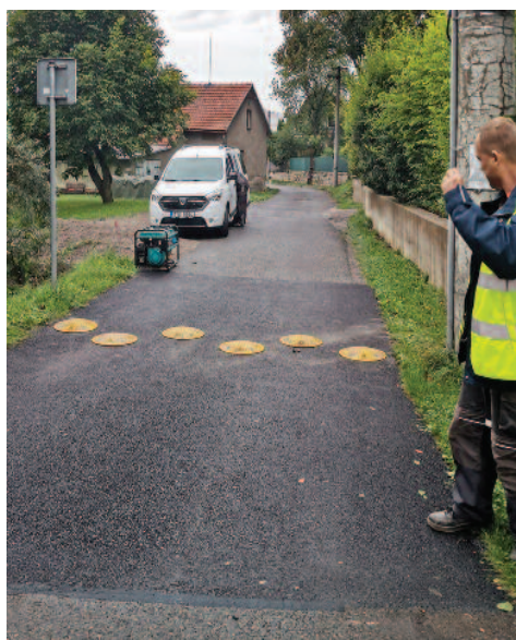
Pro větší bezpečnost na ulici K Pastevníku byla provedena oprava zpomalovacího retardéru.
