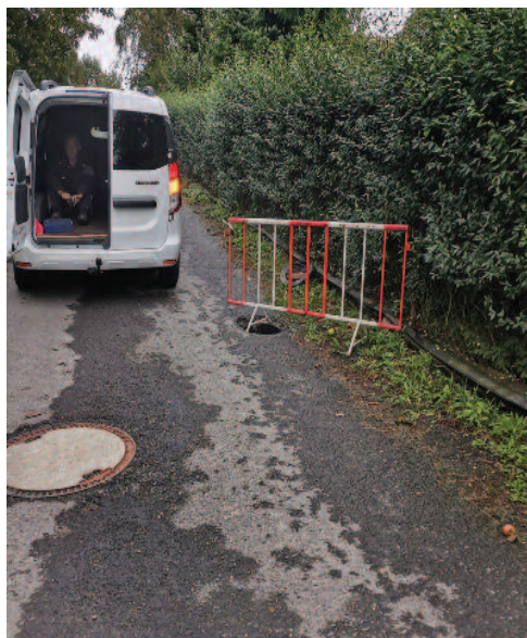
Bylo provedeno zabezpečení propadlých dešťových vpustí a kanalizačních šachtic ve městě.
