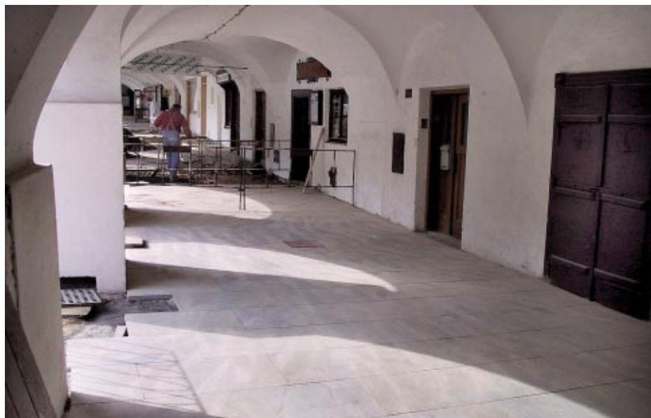
Na podloubí brušperského náměstí se pokládá nová, jednotná pískovcová podlaha. Posléze budou pokračovat další úpravy. Jak postupují stavební práce je možno vidět na obrázcích.
