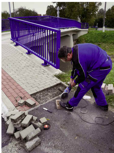
Cvekův most, závěrečné práce na chodníku.
