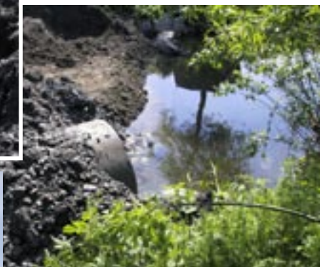
Na stavbě Čističky odpadních vod protíná kanalizace „Na zátočině“ řečiště Ondřejnice
