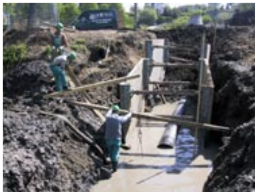
Na stavbě Čističky odpadních vod protíná kanalizace „Na zátočině“ řečiště Ondřejnice
