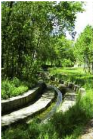
Horní Kotbach pod přehradou
