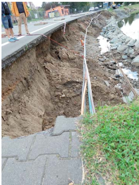
Výtrž pravobřežní části Ondřejnice–Brušperk Střed.
