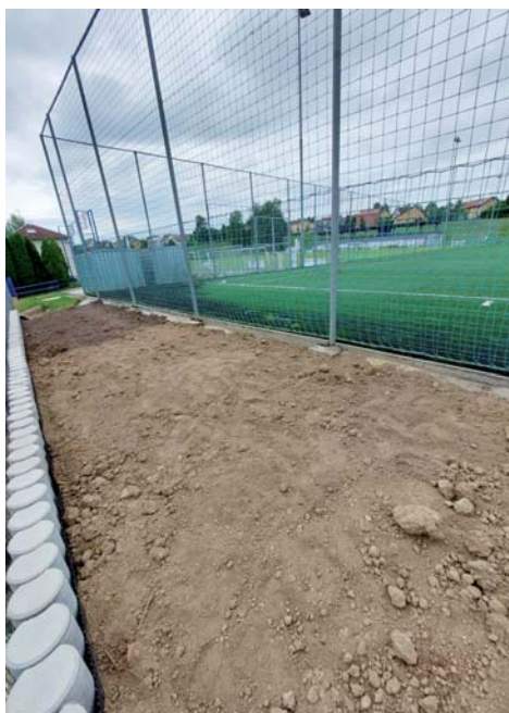
Oprava ujíždějícího svahu u velké umělky.
