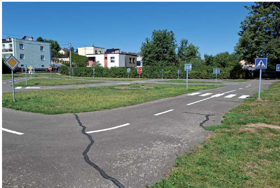
Obnovené dopravní hřiště.
