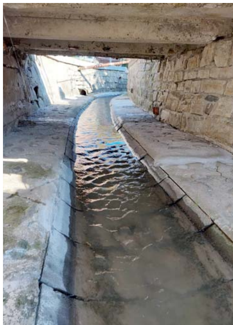
Opravy na dolním toku Horního Kořbachu.
