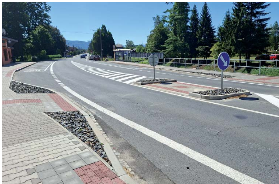
Přechodové místo v lokalitě zastávek Brušperk Střed.
