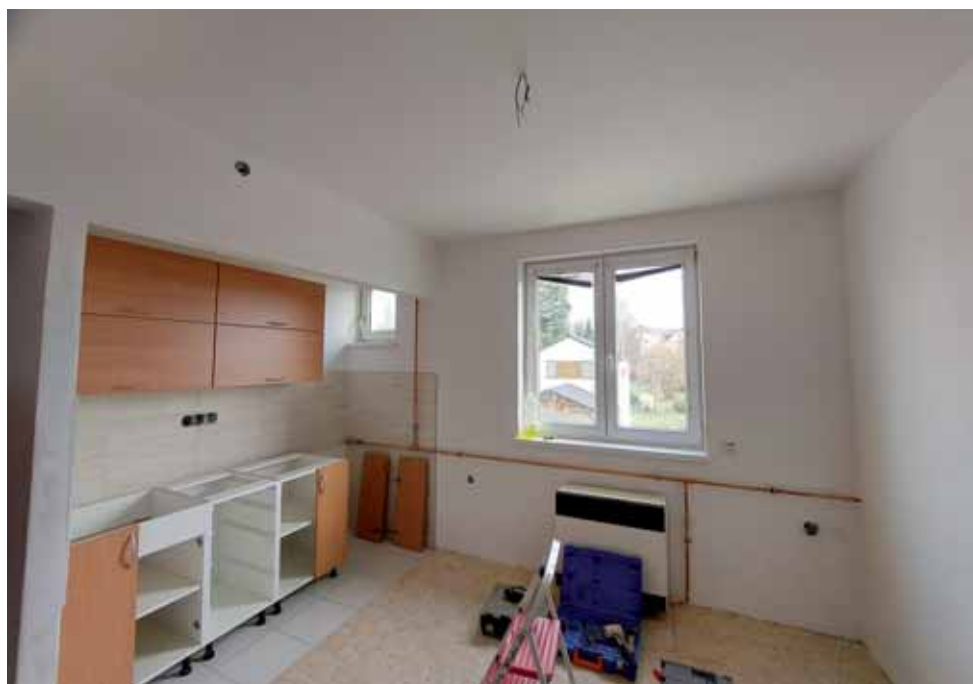
Rekonstrukce bytů v obecních domech.
