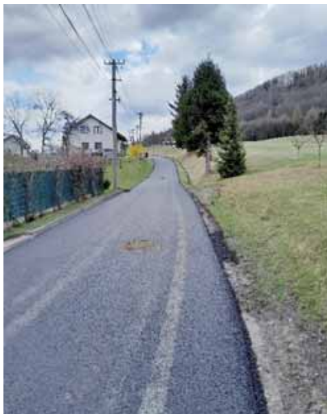
Nový asfaltový povrch MK na kanalizační stoce.
