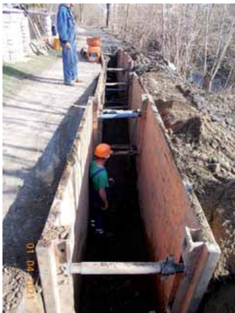
Příprava pro pokládku kanalizační stoky.
