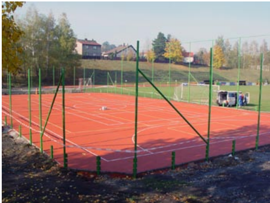
Víceúčelové hřiště na sportovním stadionu má hotovou hrací plochu
