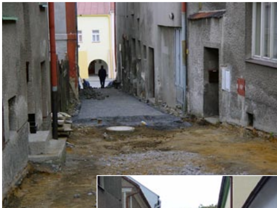
Dobudovává se část odpadní stoky Na Drahách
