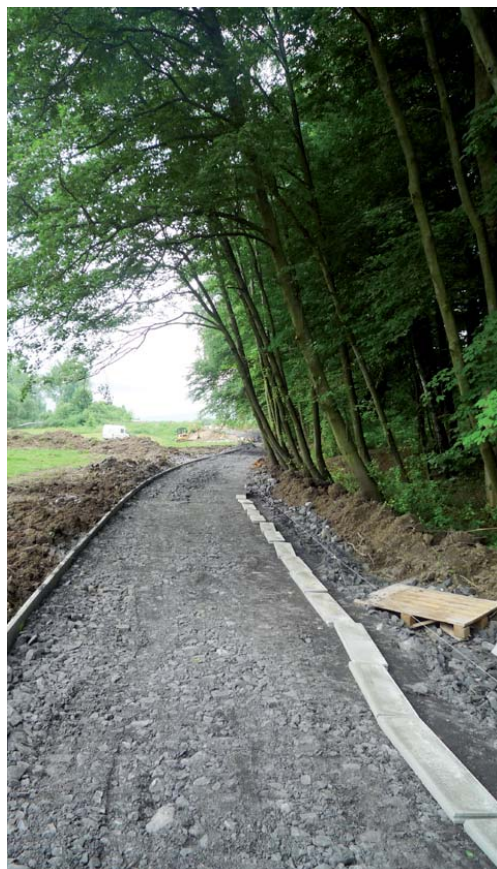
Budování nové cyklotrasy do Staré Vsi
