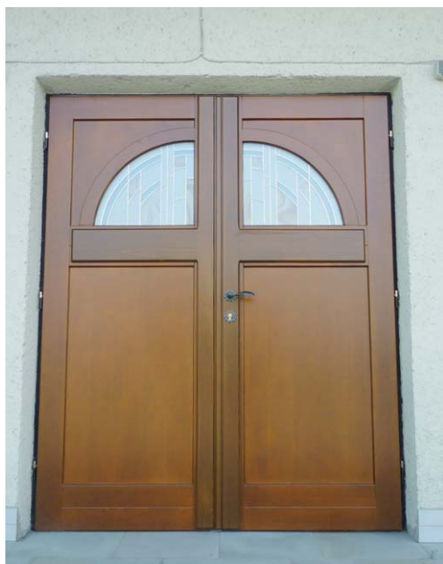
Nové vstupní dveře do smuteční kaple
