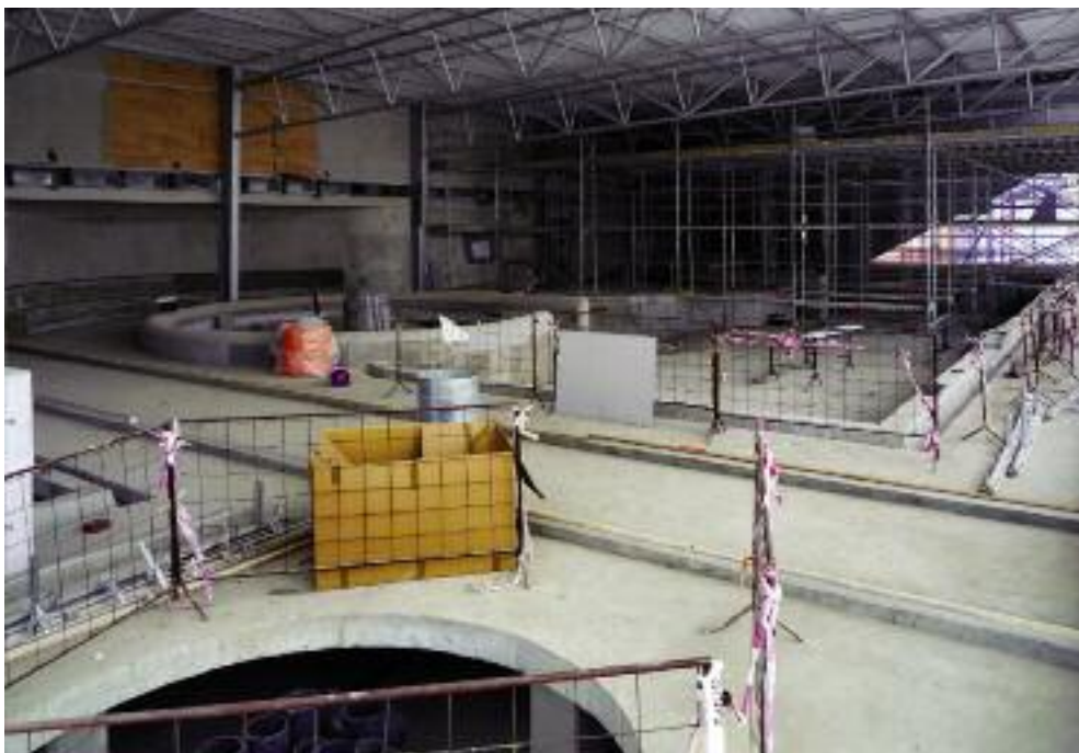
Práce v krytém plaveckém bazénu pokračují
