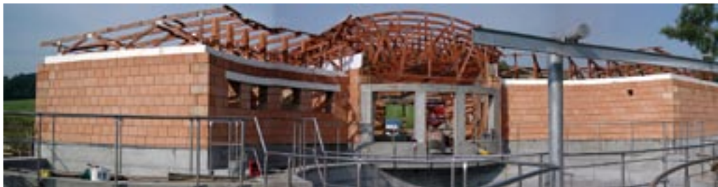
Panoramatický pohled na celé staveniště čističky odpadních v
