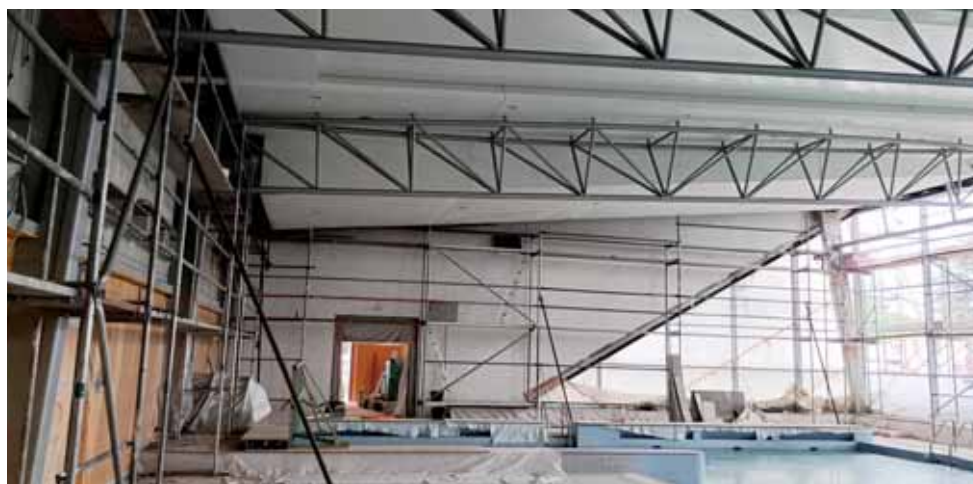
Oprava obvodového pláště bazénu.
