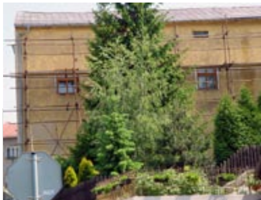
Oprava jižní fronty městského úřadu
