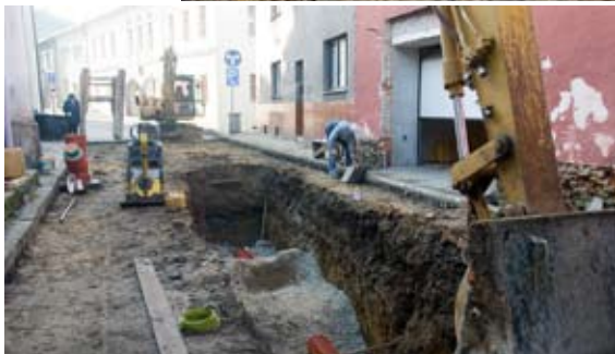
Rekonstrukce kanalizace a vo- dovodního řadu na části ulice K Náměstí. Investorem stavby jsou Severomoravské vodovody a kanalizace, a. s.
