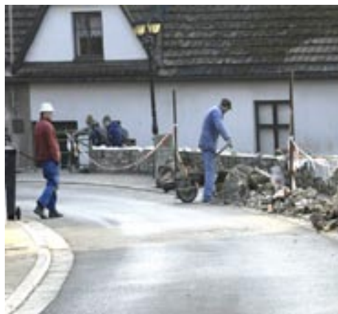
Oprava zídky na „Barovém kopci“ spěje k dokončení
