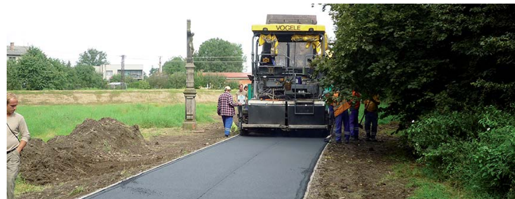
Výstavba nové cyklotrasy č. 6135 z Brušperku do Staré Vsi n. O.
