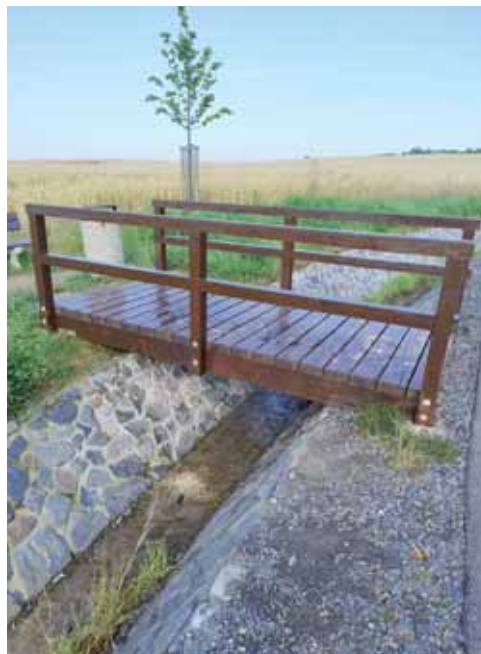
Opravený byl také dřevěný mostek na nové stezce nad Obloukem.
