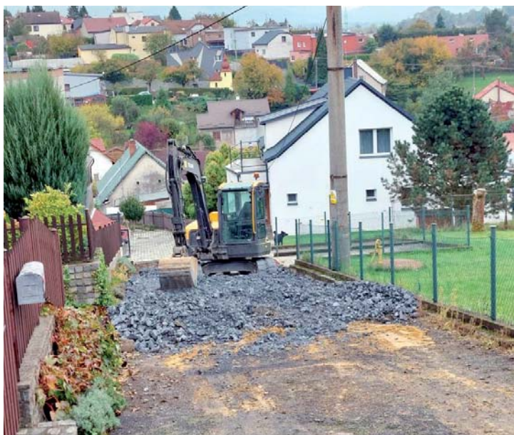
Na ulici Valy byly zahájeny práce na opravě části této komunikace (slepá odbočka k RD).
