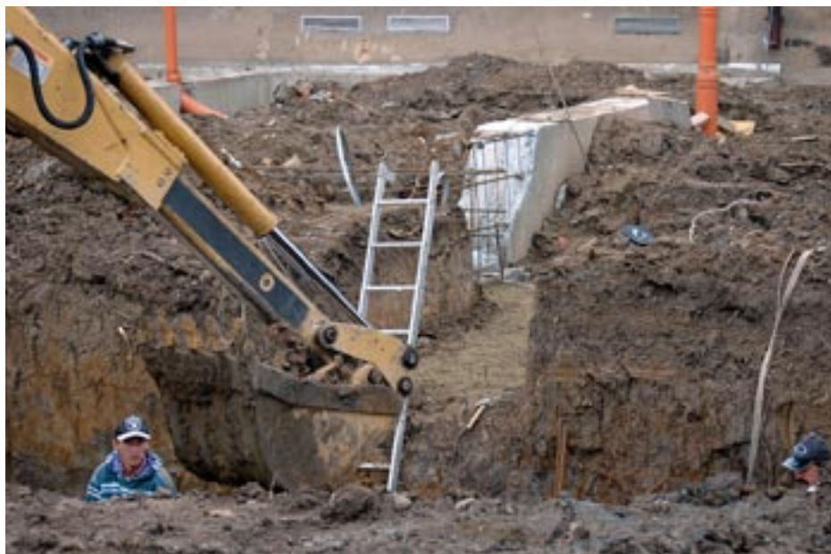
Na stavbě sportovní haly finišuje výstavba základů pro stavbu nadzemní konstrukce
