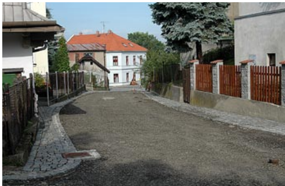
Na ulici Dráhy byl připraven povrch k položení živичného koberce. Když budete tyto fotografie prohlížet, bude už ulice upravená
