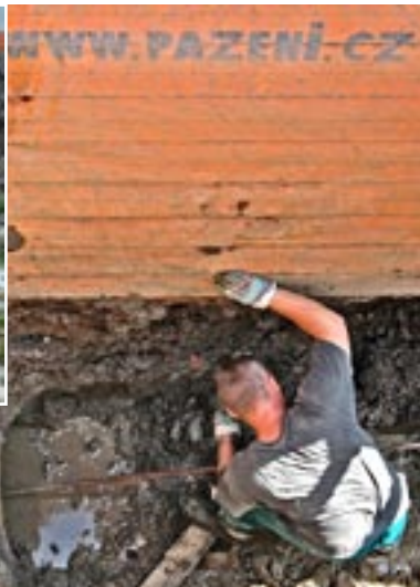
Na Fryčovické ulici komplikuje stavbu mokré podloží a hmotnost zeminy svahu pod náměstím. Část již uloženého potrubí kanalizace byla touto silou rozdrčena
