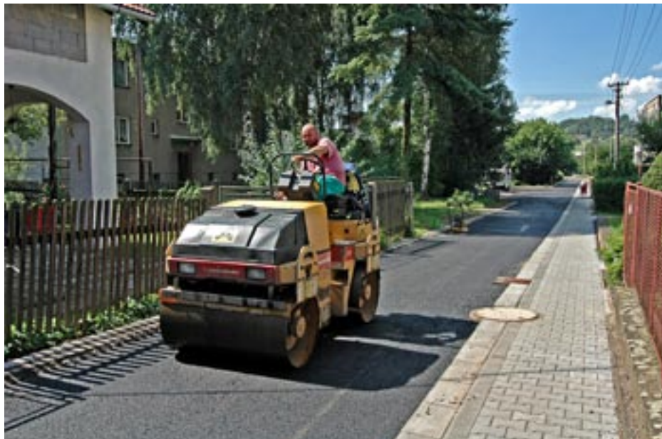
Na Policejní ulici byl po uložení kanalizačního potrubí postaven nový chodník a položen živичný koberec
