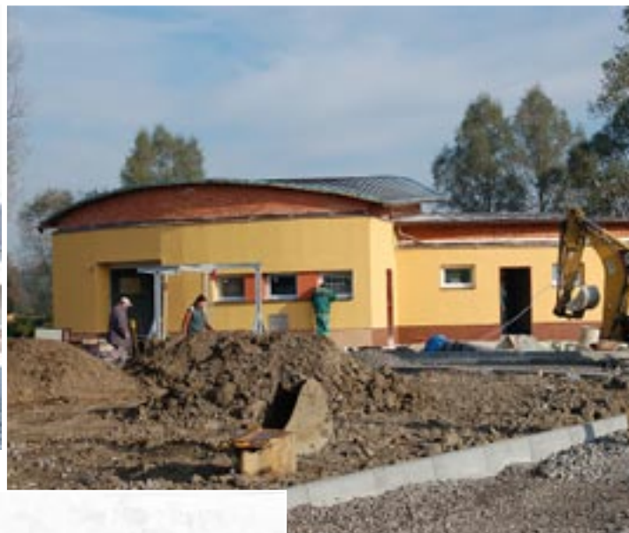
Budova ČOV je hotová a dokončují se venkovní úpravy. I technologie je téměř dokončena.
