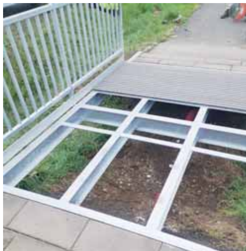
Vyměněná lávka přes vodoteč na mimoúrovňovém chodníku vedoucím směrem na Fryčovice.
