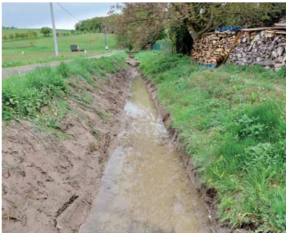
Vyčištění koryta potoka odvádějícího vodu ze svahů tzv. Cvekova lesa.
