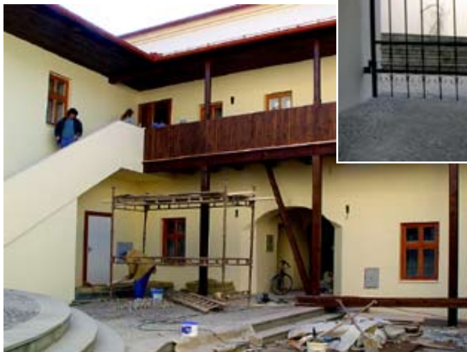
Atrium městské radnice se opravovalo celý podzim
