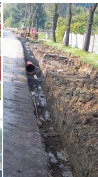
Začaly rovněž opravy vodovodního řádu na ulici K Náměstí
