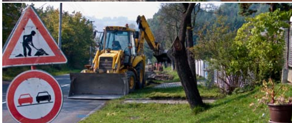
Na Krmelínské ulici se staví chodník směrem na Petřín
