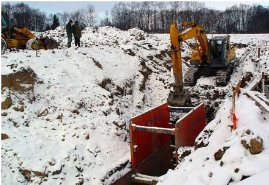
Na „Zátočině“ se pracuje v hlubokých výkopech pro pokládku potrubí. Jsou to nejhlubší výkopy na celé stavbě ČOV.
