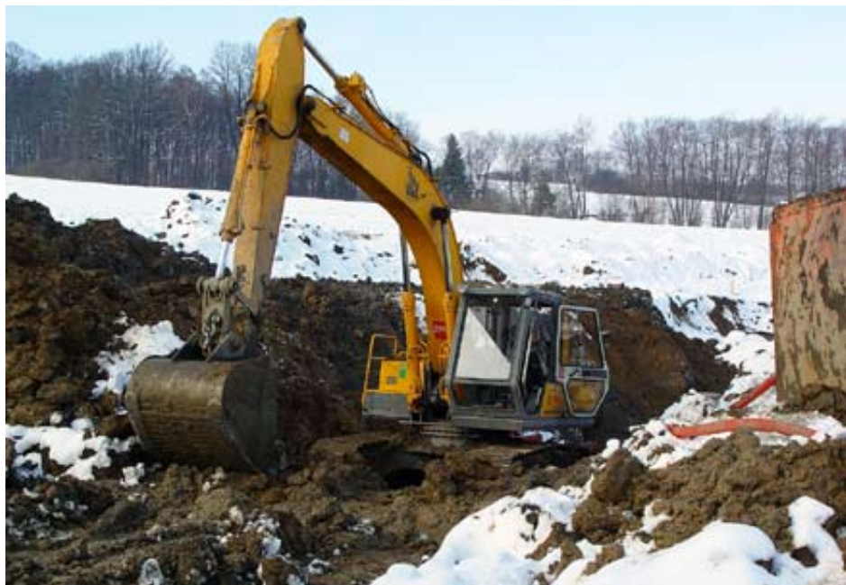
Na „Zátočině“ se pracuje v hlubokých výkopech pro pokládku potrubí. Jsou to nejhlubší výkopy na celé stavbě ČOV.
