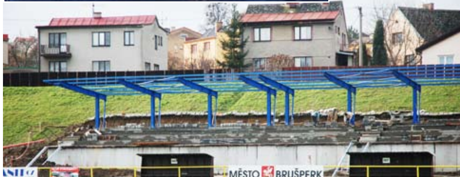
Tribuna na stadionu SK Brušperk je již zastřešená
