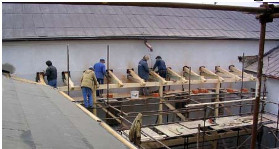
Na rekonstrukci radnice se ještě pracuje.
