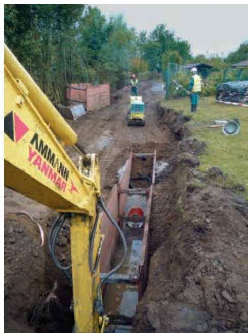
Práce ve městě — stavba kanalizační stoky pro odvod splašků do čistírny odpadních vod
