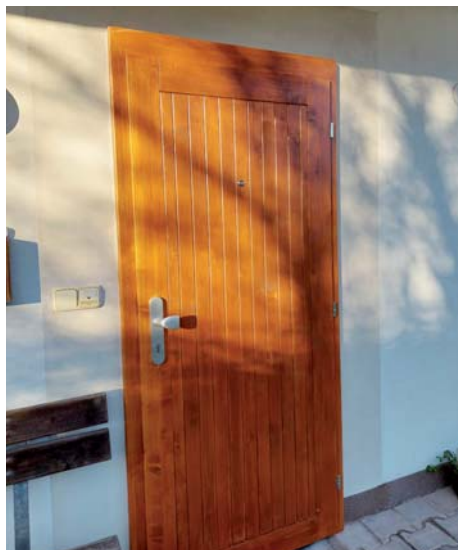
Výměna vstupních dveří na bytovém domě č. p. 1086.
