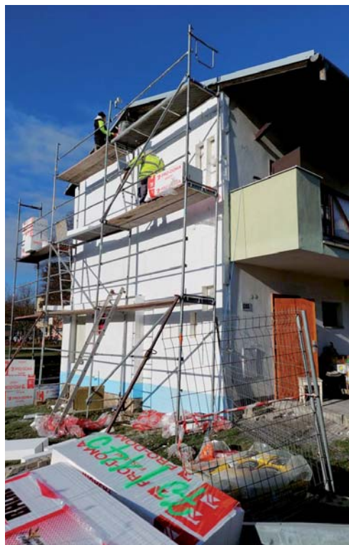
Zateplení štítových stěn bytového domu č. p. 1086.
