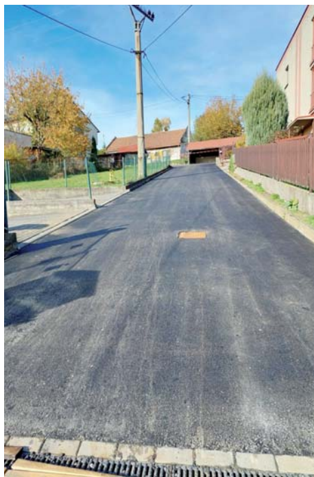
Opravená část ulice Valy po dokončení prací.
