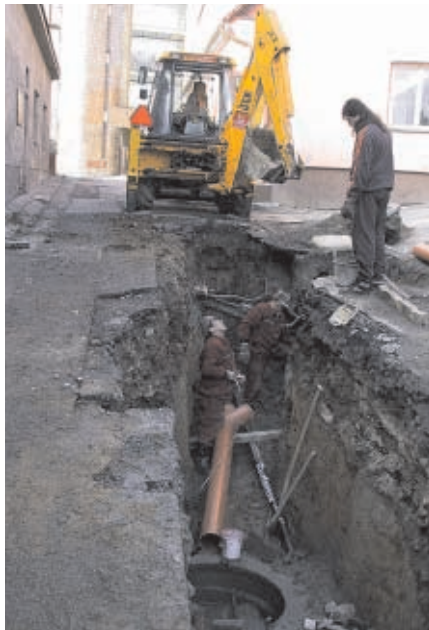
Příznivé počasí prálo v únoru stavbařům, kteří na Bárovém kopci instalovali nové vedení vodovodního řádu a pokládali novou kanalizaci.
