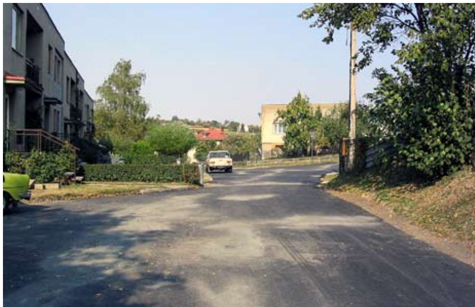
Oprava položení živičného povrchu na ul. Gruntovní.
